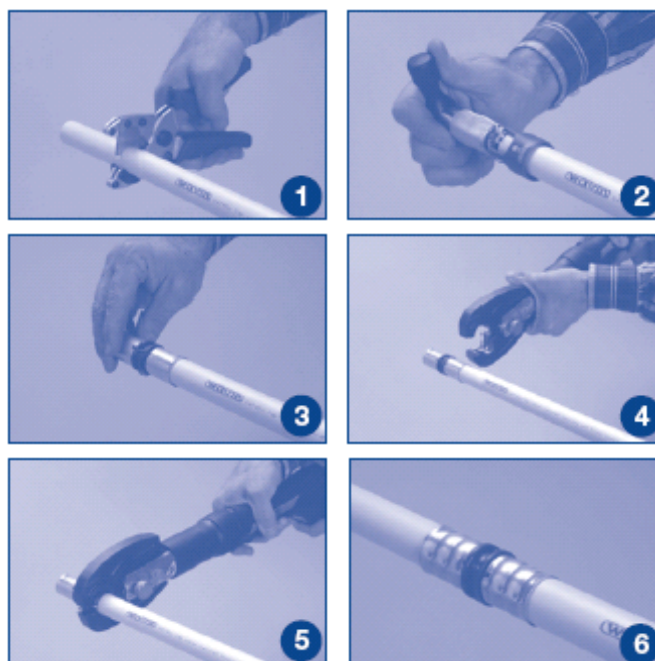
Fig. 1: Procedure montage "Tigris M1" en "Tigris K1"
