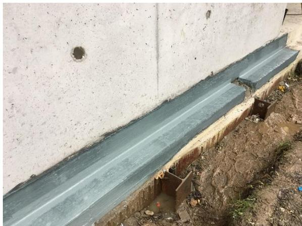
Image 2: – solin réalisé à l'aide d'une bande de joint de Type VF
