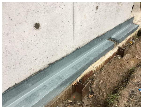
Fig. 2 – kimnaad m.b.v. voegenband Type VF
