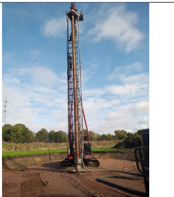
Fig. 2 : Réalisation du pieu à refoulement
