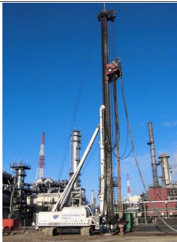
Fig. 2 : Voorbeeld van een palenmachine met een Omega boorkop
