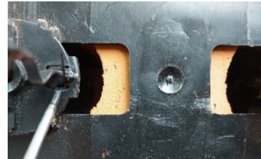
Fig. 6 – Demonderen van de gevel
