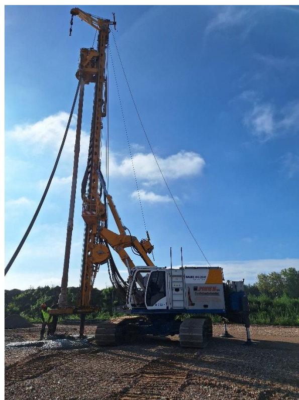
Fig. 2 : Exemple de machine à pieux
